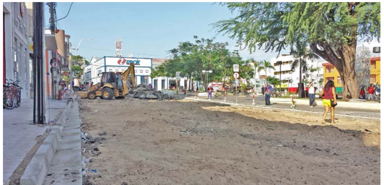
Obras de substituição do asfalto por blocos intertravados tiveram início no entorno da Praça de Cuba
