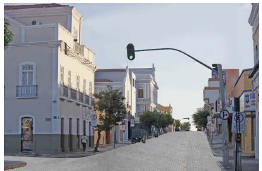
Projeção da fiação subterrânea e pavimentação com blocos intercalados na Avenida Dom José
