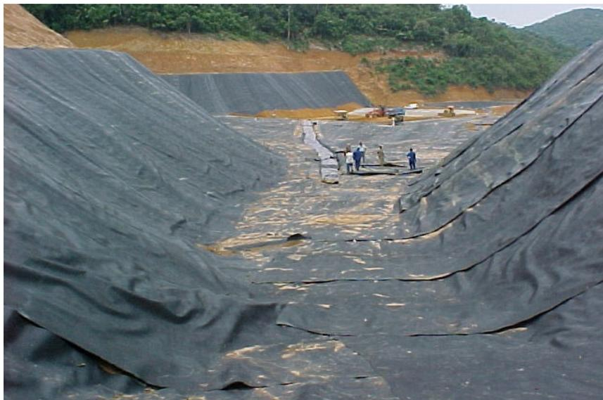
**Figura 22: Preparação de trincheiras para a disposição adequada de resíduos sólidos**
