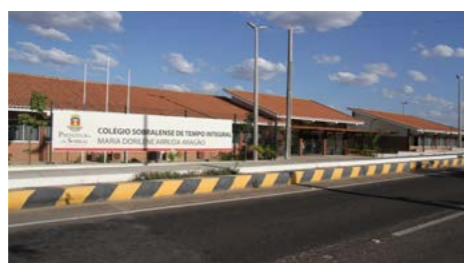
Colégio Sobralense Maria Dorilene Arruda Aragão, primeiro de 18 que estão sendo construídos.
