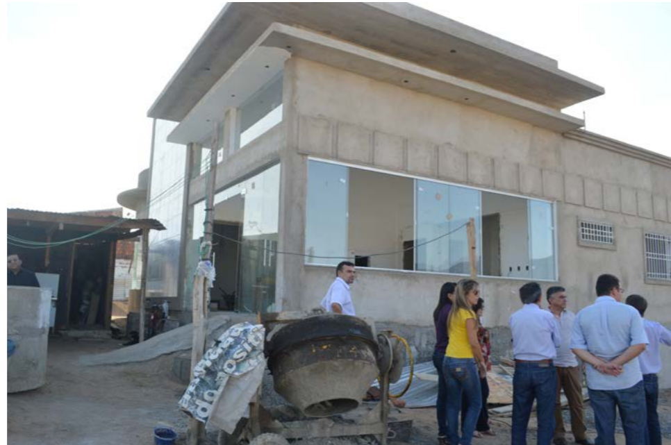
Novo Centro de Saúde da Família do bairro Terrenos Novos está com 63% das obras prontas
