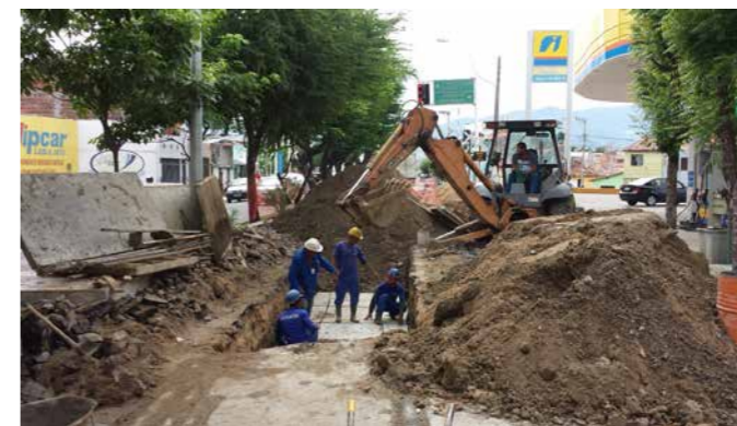
Obras de drenagem na rua Deolindo Barreto, no Centro da cidade.
